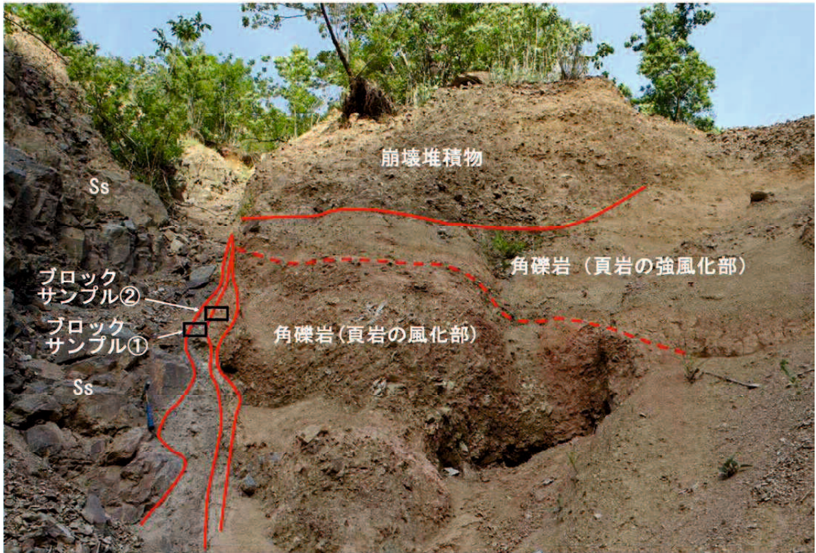
図-4.30 岩盤と角礫岩卓越層との境界写真 (SK4-①)
