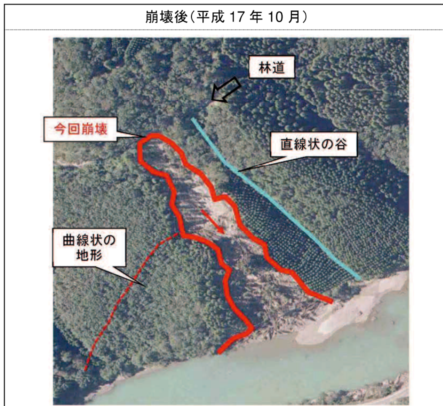
図-5.1 山須原深層崩壊箇所の崩壊前後の航空写真判読
