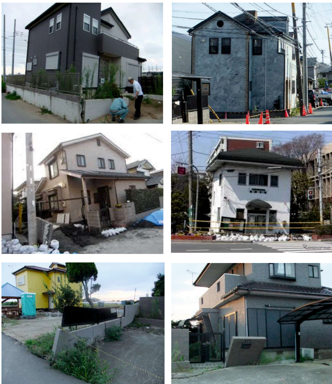
写真1.1.1 千葉県浦安市における液状化による不同沈下
