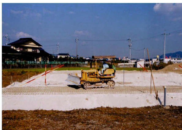
写真 3.6 盛土転圧状況 6)7)
