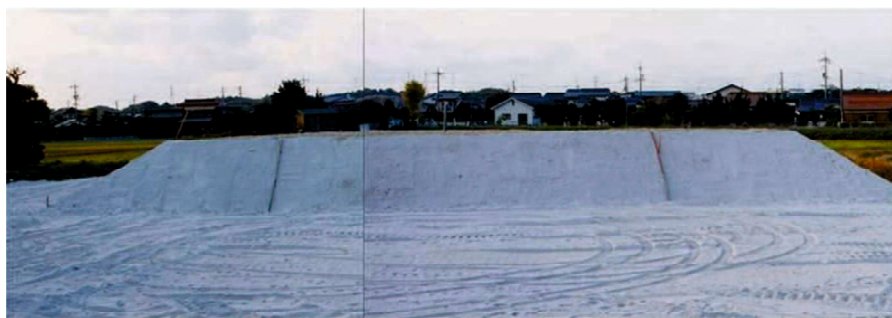
写真 3.2 試験盛土の完成状況
