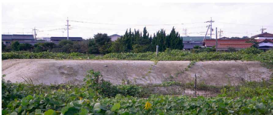
写真 3.3 施工後 10 年以上が経過した試験盛土外観写真
