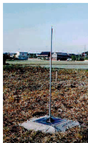
写真 3.4 沈下板外観写真 6)7)
