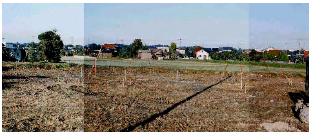
写真 3.5 沈下板および観測井戸設置後 6)7)
