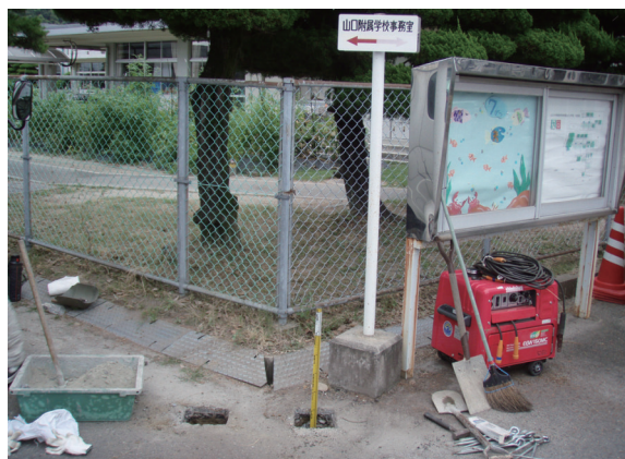
写真37 調査区全景 (東から)
