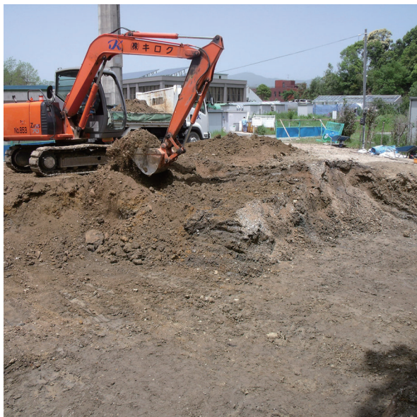
写真9 重機掘削の様相(南東から)
