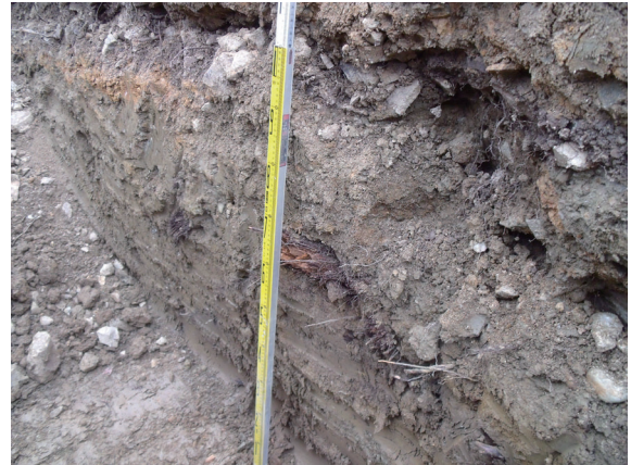
写真 22 A 地点北壁土層断面 (南東から)
