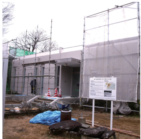
写真31 改修工事風景(南西から)
