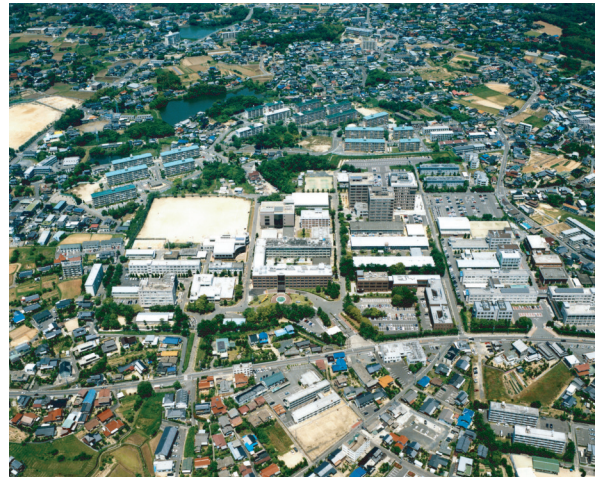
写真5 常盤構内航空写真 (南から)
