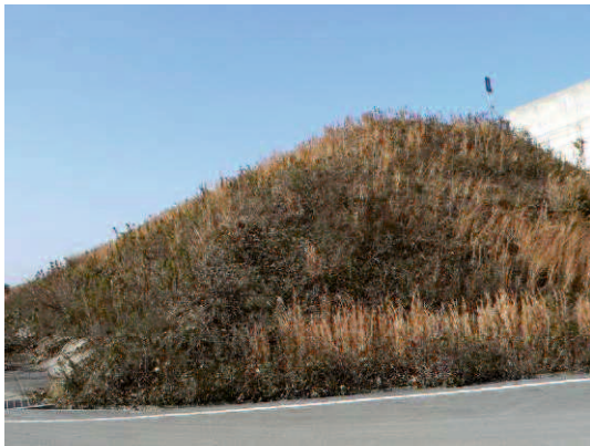
写真 3.5-18 全体像(相原大橋方面南より)
