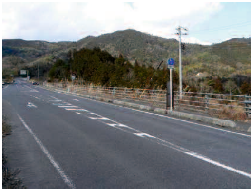
写真 3.5-1 盛土天端道路
