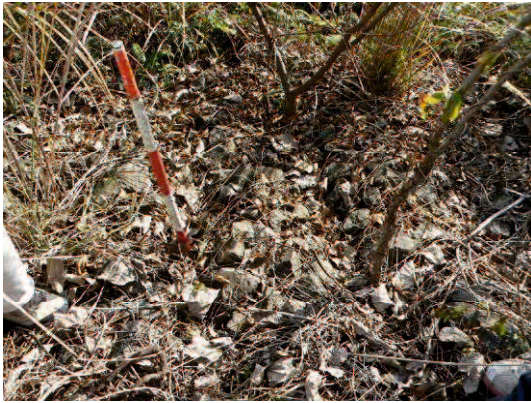
写真 3.5-15 蛇籠の様子(斜面上より)
