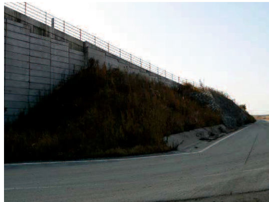
写真 3.5-19 全体像(相原大橋方面北より)
