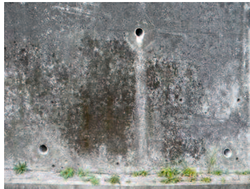
写真 3.5-9 盛土下擁壁排水孔
