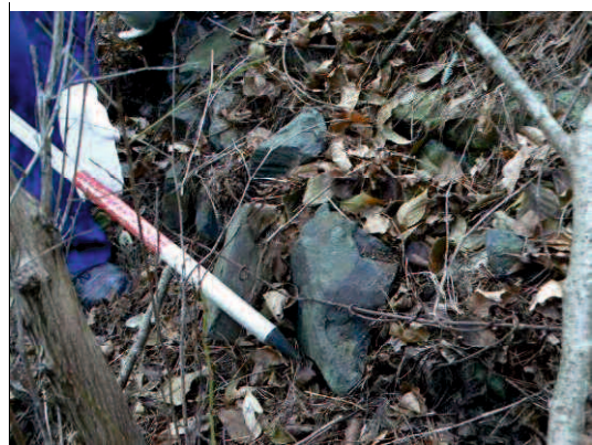
写真 3.5-16 蛇籠より散乱した礫
