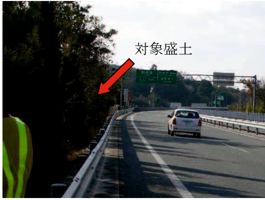
写真 3.5-12 対象盛土の位置
