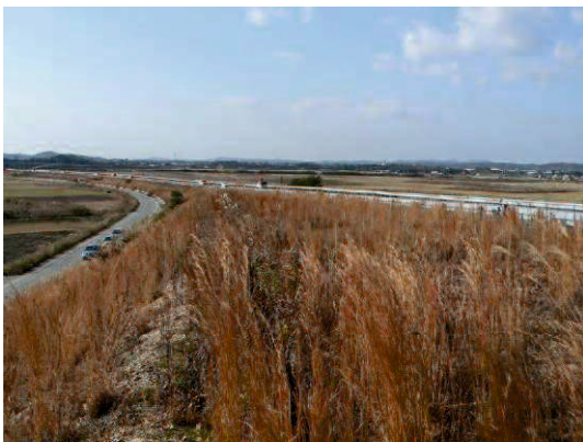
写真 3.5-20 盛土天端(相原大橋方面より)
