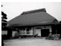
写真 3.1 伝統民家の南面外観
