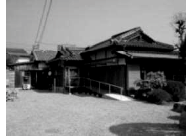
写真 4.1 対象民家の外観
