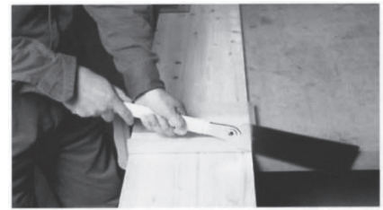
7 ジグとこの身の間にはすき間がないことを確かめながら、この身のもとを板材の角に当て、軽くひき始める。
