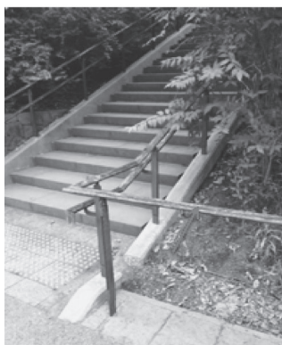
階段下, 雨水排水 が集まる所
