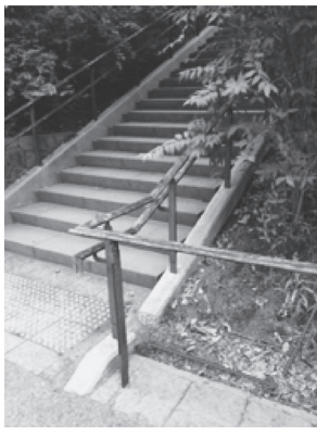
階段下,雨水排水 が集まる所
