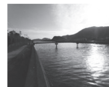
④河口付近
