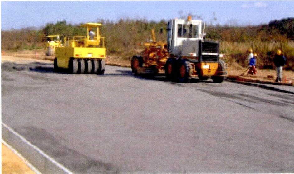
写真-1.1.1 クリнкаアッシュの路盤材料としての適用事例
