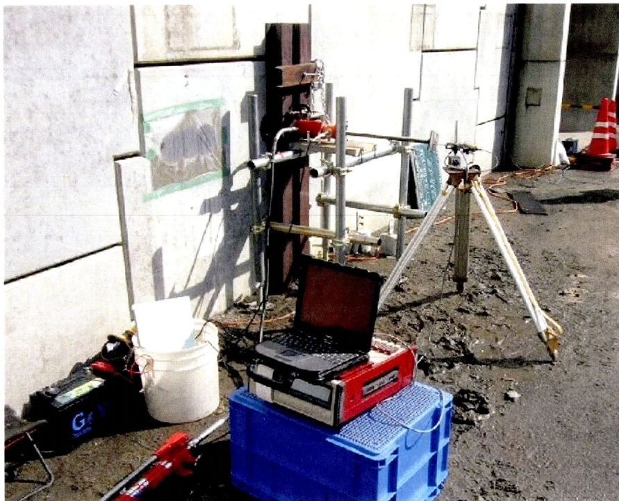
写真-4.4.1 引抜き試験装置
