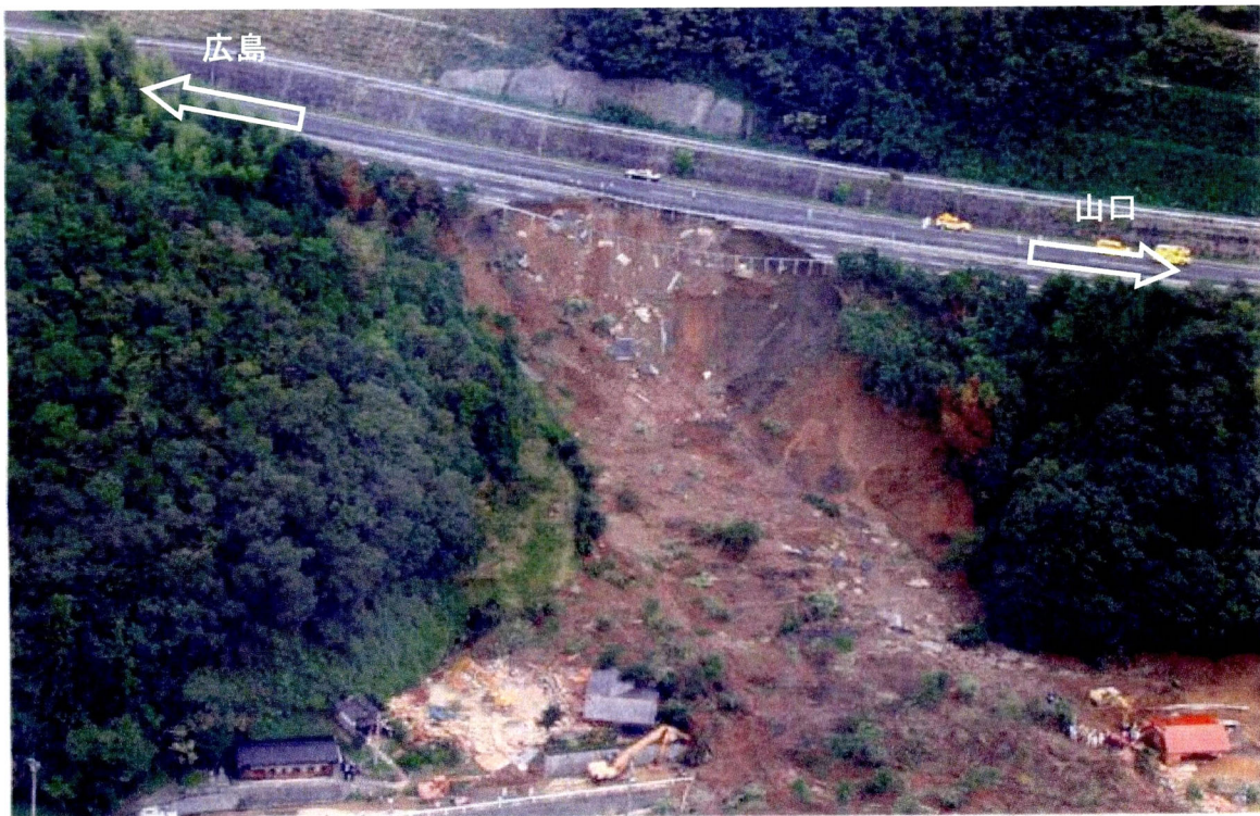
写真-4.5.2 被災箇所
