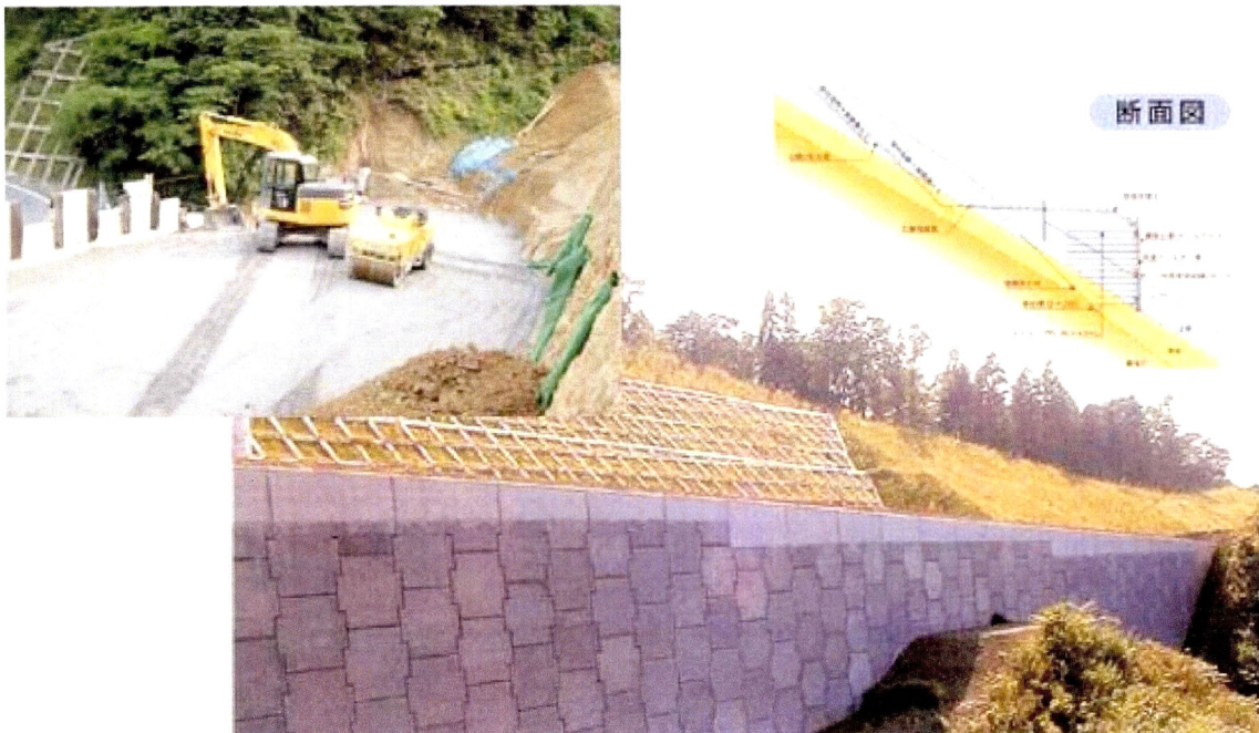
写真-1.1.2 クリнкаアッシュの裏込材料としての適用事例
