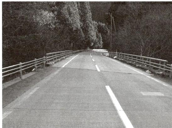
写真-4.3.1 パイプヒーティング路面（葉の内3号橋）
