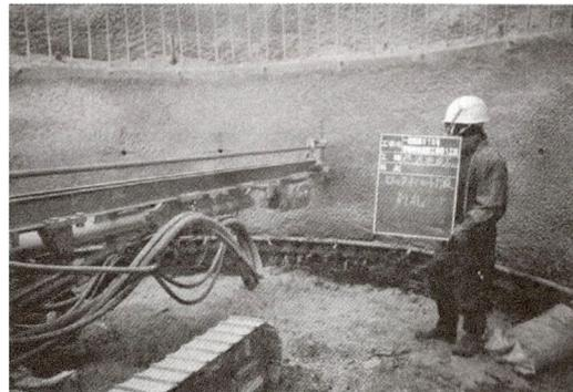
写真-3.2.2 ロックボルト施工状況
