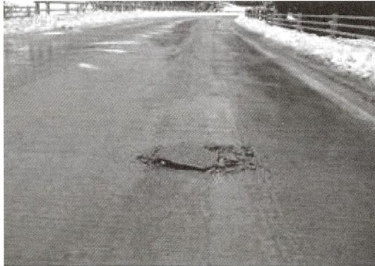
写真-6.2.1 パイプヒーティング路面に発生した損傷
