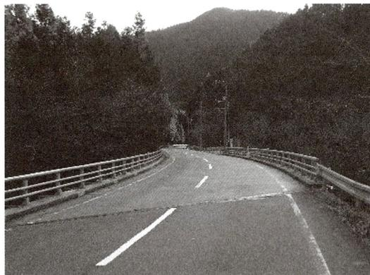
写真-4.3.2 パイプヒーティング路面（葉の内4号橋）
