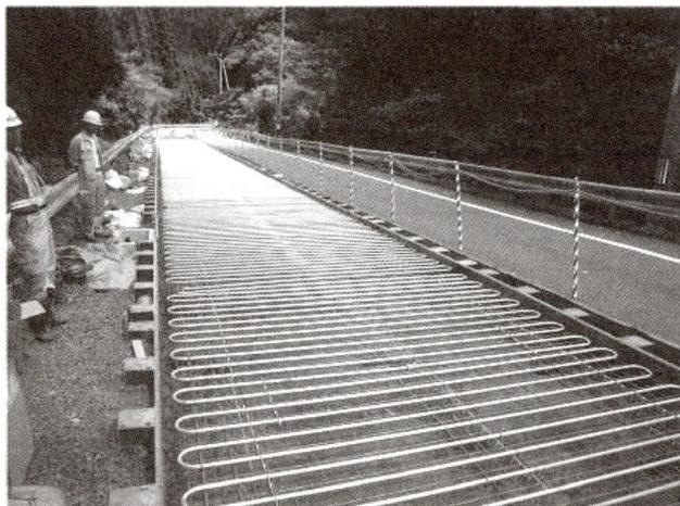
写真-3.3.1 土工部のパイプヒーティングパネル設置状況
