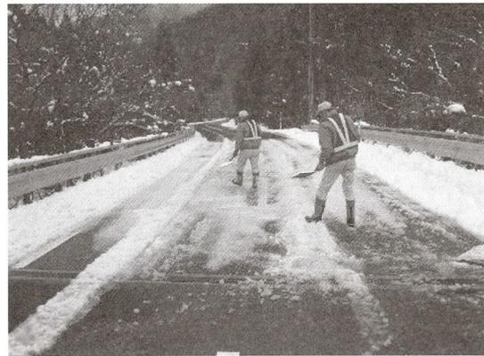
写真-1.1.10 凍結防止剤散布状況
