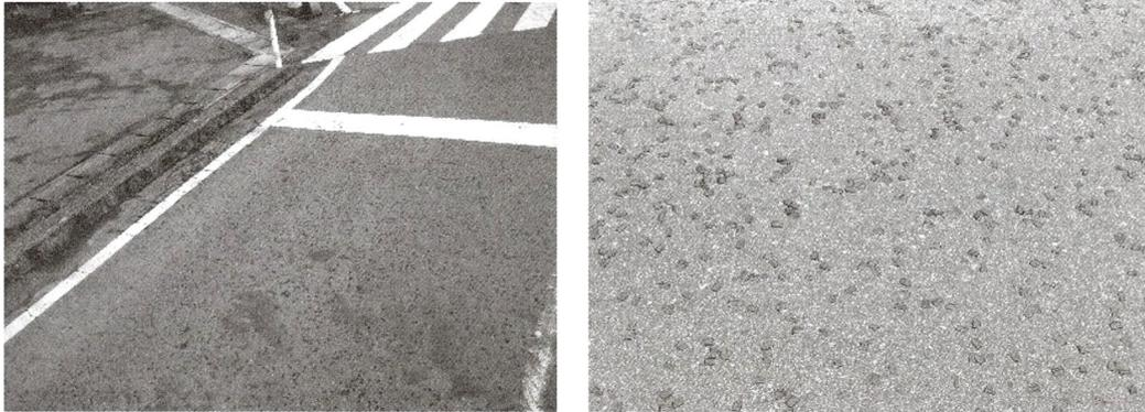
写真-1.1.16 凍結抑制舗装（交差点付近）
