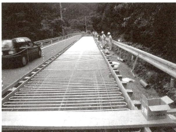
写真-3.3.2 片車線でのパイプヒーティングパネル設置状況
