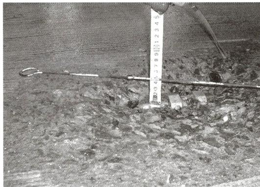
写真-6.2.2 ポップアウトにより露出したパイプ継手
