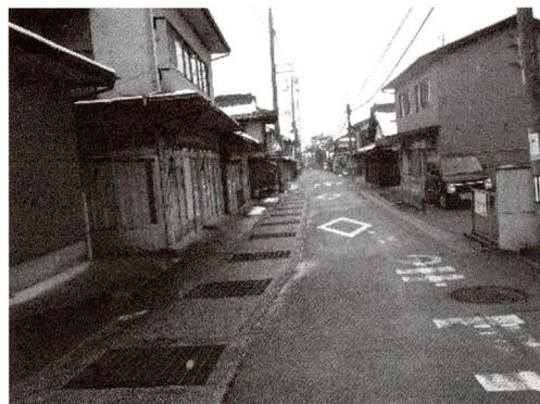
写真-1.1.13 流雪溝の設置例
