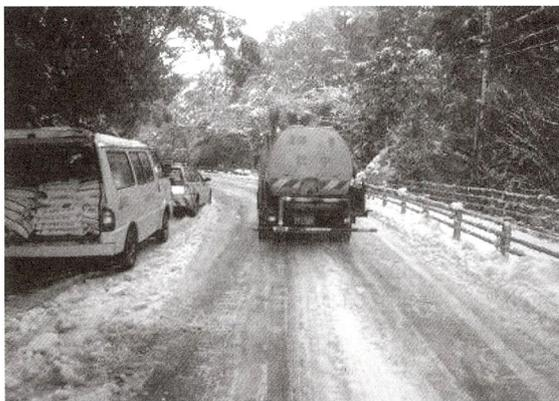
写真-1.1.3 凍結防止剤（溶液）の散布状況
