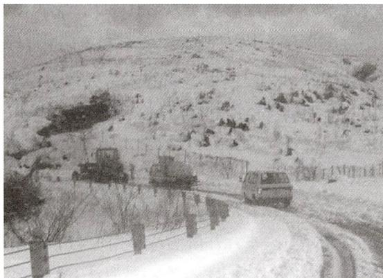
写真-1.1.4 凍結防止剤散布作業状況
