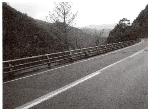
写真-1.1.14 下り坂での凍結抑制舗装
