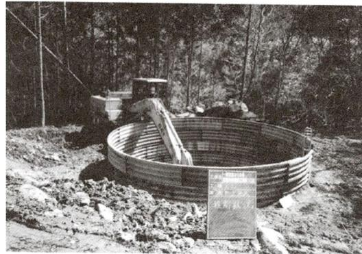
写真-3.2.1 地下タンク施工状況（掘削）
