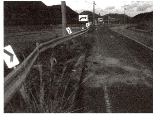
写真-1.1.12 スリップ事故による破損
