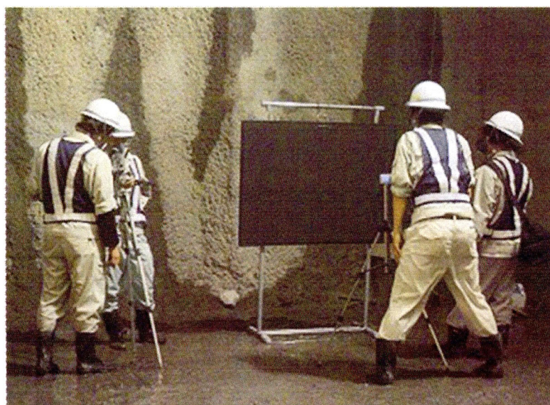
写真 5-1 ブラックパネルとデジタルカメラでのフラッシュ撮影状況
