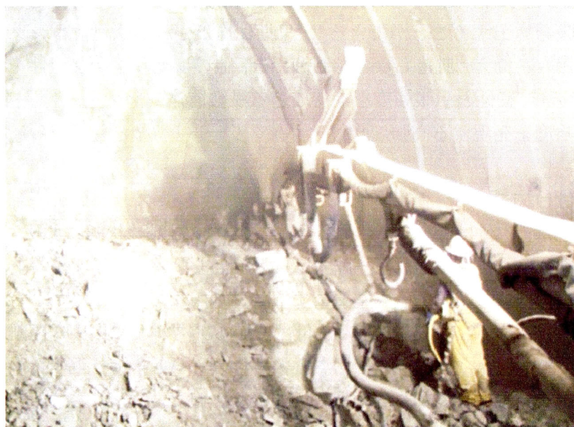
写真 2-1 吹付けコンクリート作業の状況
