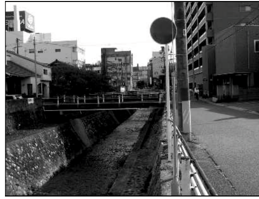
図 5-3：コンクリートブロック工法による一の坂川
