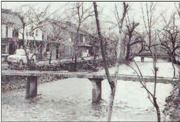
図5-1：昭和39年、改修前の一の坂川の様子 現在よりも河床が浅く、水面が近くにあった。 護岸は石積みによるものが中心だった。
