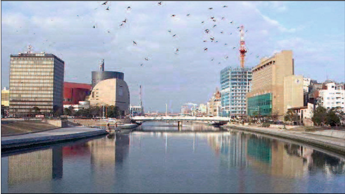
図 4-6 整備後の紫川河口付近：河川両岸に散策路ができ、新たに商業施設もつくられた。
