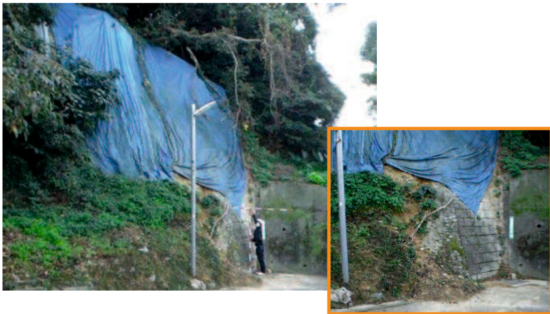
写真 4-2 現地状況写真 (201- I -0074)
