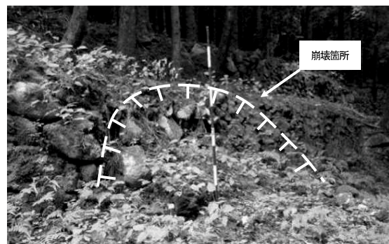
写真-2 ID35の状況 (安全な箇所)
