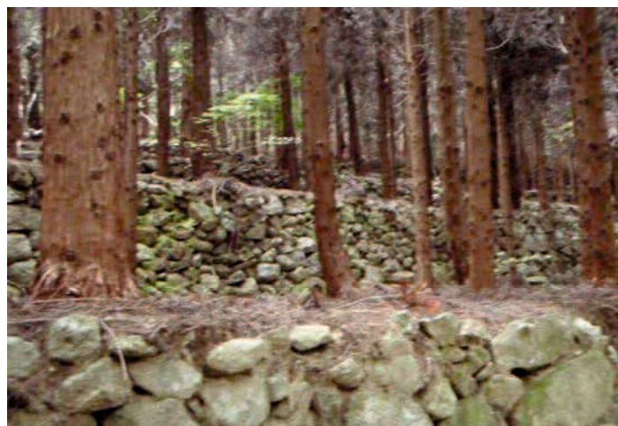
写真 3-2 ID35 の状況 (安全な箇所)
