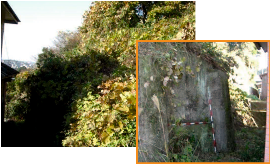
写真 4-1 現地状況写真 (201- I -0251)
