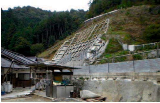
写真-2 現地状況写真 (208-I-0130)
