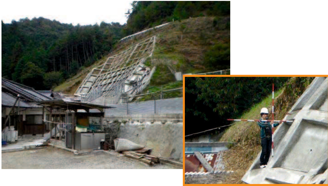
写真 4-3 現地状況写真 (208- I -0130)
