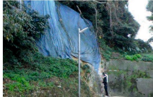
写真-1 現地状況写真 (201-I-0074)
