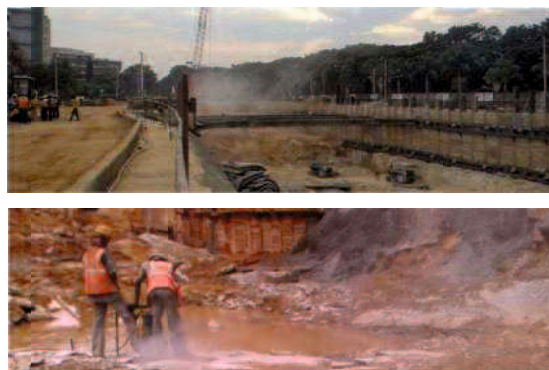
写真-1 インド地下鉄開削工事現場
