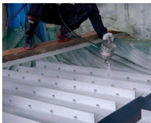
写真-6.2 接着剤塗布状況
