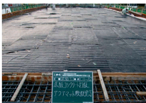
(e) 養生マット設置状況
