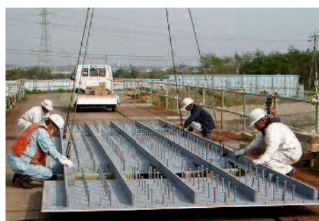
(b) 吊りワイヤー設置状況
