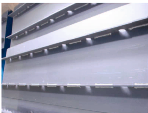
写真-6.1 塗布前の底鋼板
