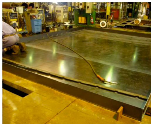
(b) 側鋼板溶接
