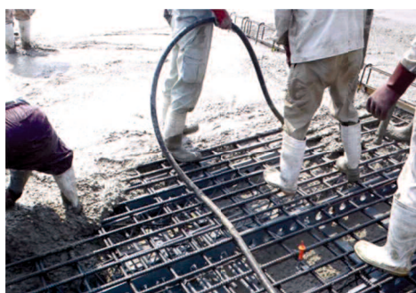
(c) コンクリート打設
