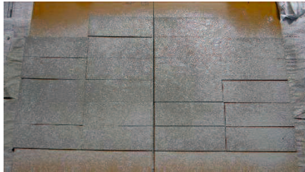
写真-2.8 接着剤塗布後の鋼板
