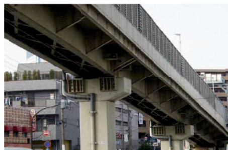
写真-1.2 枝川ランプ橋（1979年） 16)
