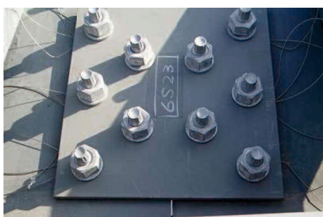
(e) パネル連結状況
