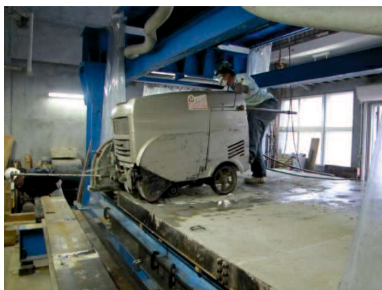
写真-5.4 供試体切断状況
