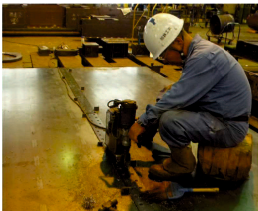
(a) 底鋼板ボルト孔加工
