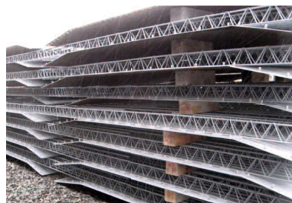
(d) 鋼板パネル保管状況
