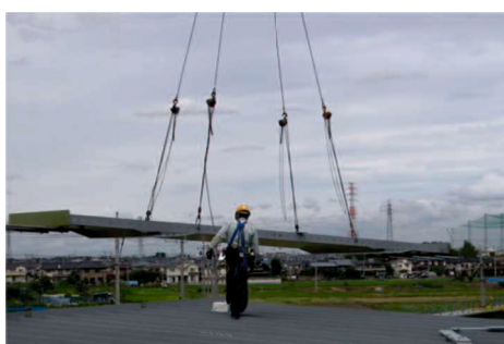
(c) 吊り状況
