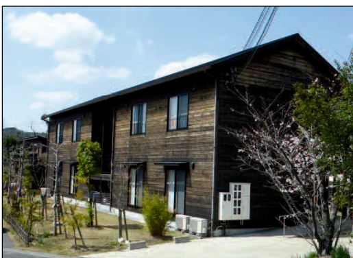
写真3-11 宿泊施設（新設）外観
