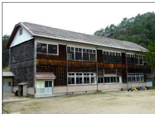
写真7-2 木造校舎(活用想定施設)
