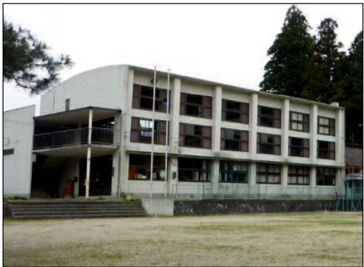
写真7-3 RC校舎兼体育館
