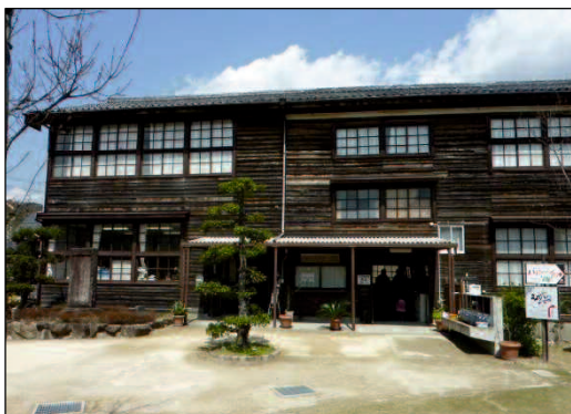
写真3-7 校舎（改修）外観
