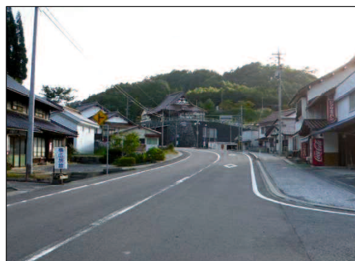
写真7-6 前面道路(広島市方向)
