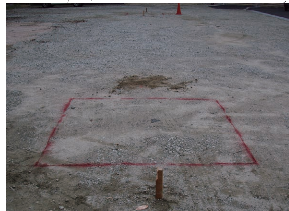
写真7 A・B調査区調査前全景(西から)
