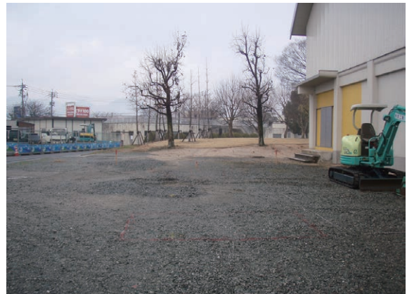
写真28 調査前全景 (南から)
