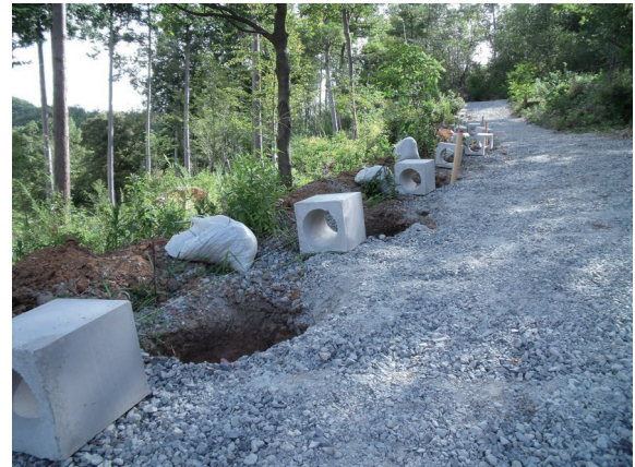
写真 40 工事の様相 (西から)
