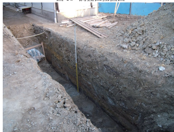
写真38 土層断面(南から)
