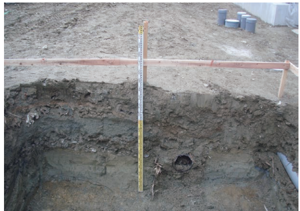
写真23 U地点土層断面(東から)
