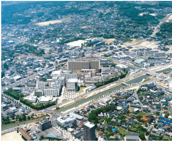
写真4 小串構内航空写真（南東から）
