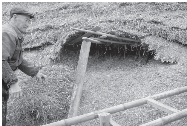
写真4-4 屋根の葺き替え
