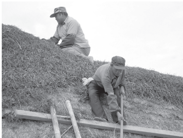
写真4-3 棟を仕上げる
