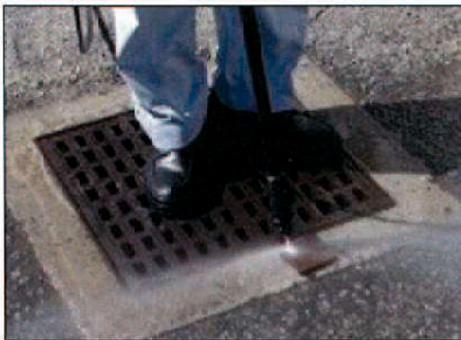
(a) 高圧水洗処理
