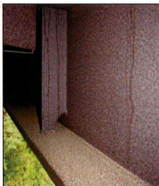
(b) 内桁⑤下フランジ上面, ⑥ウェブ面 の外観
