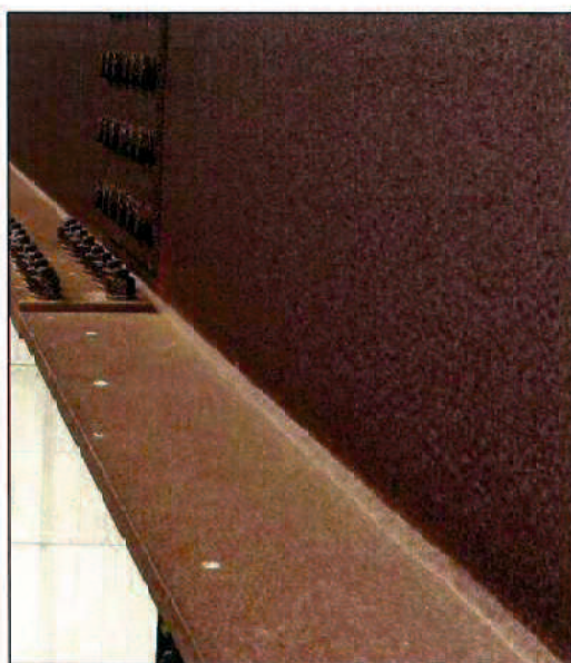
(a) 外桁⑧下フランジ上面, ⑨ウェブ面 の外観
