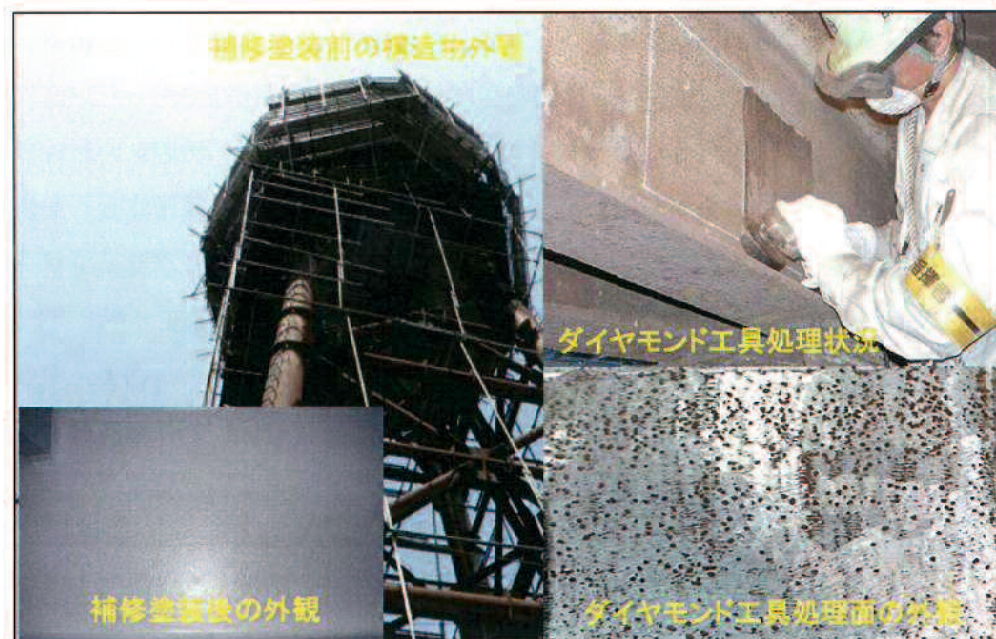
図-6.4 高架水槽全外面補修塗装に適用した実施例
