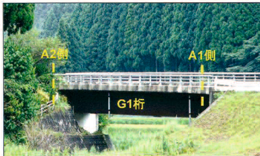
写真-7.1 山根橋全景
