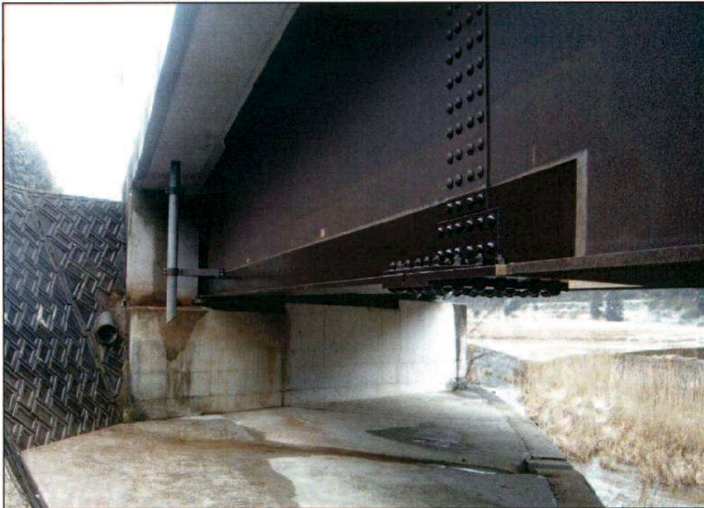
写真-7.4 補修塗装の完工状況
