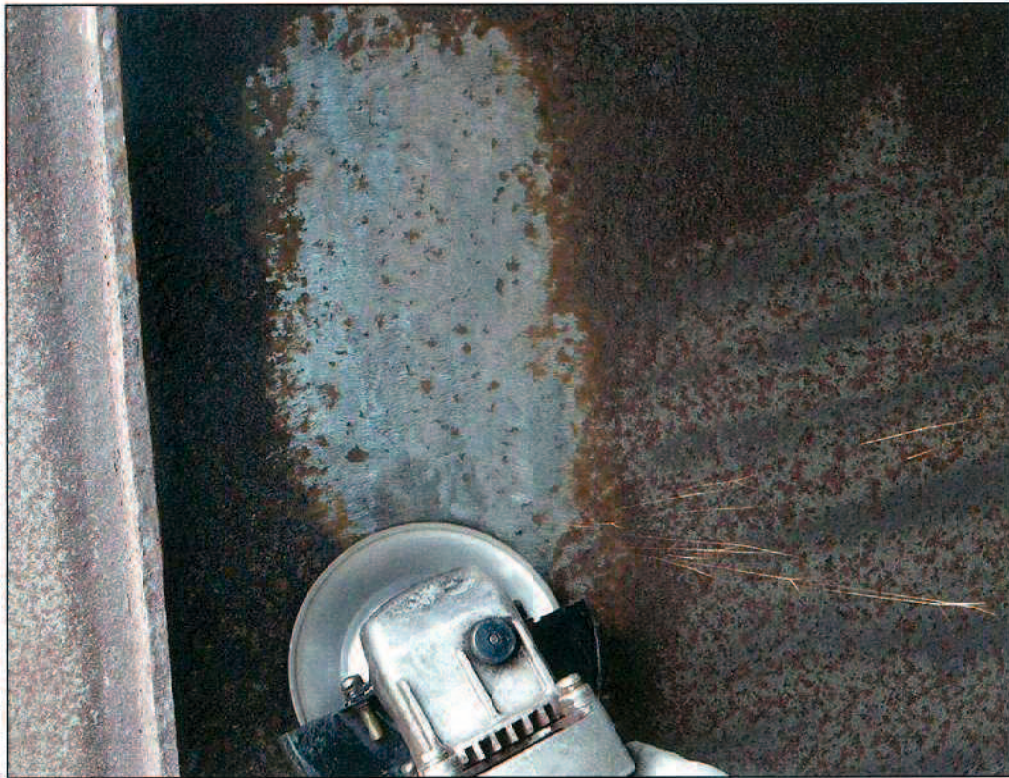
写真-6.3 ニッケル系高耐候性鋼材に形成した強固な残存さびの研削状況
