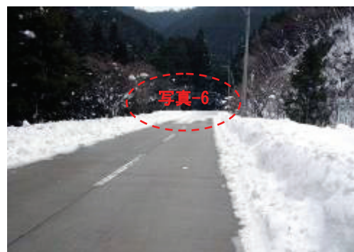
写真-5 降雪後の路面状況 (6時間後)
