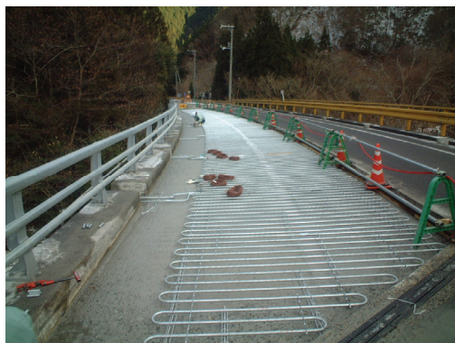
写真-1 パイプ設置状況
