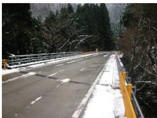
写真-2 標準運転時の路面状況
