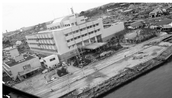
図5 津波で甚大な被害を受けた石巻市立病院の外観
