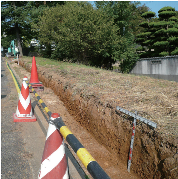
写真 139 調査区全景(南西から)
