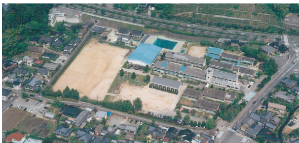
写真2 白石構内(教育学部附属山口幼稚園・小学校) 航空写真(東から)
