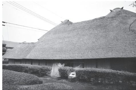
写真2 山口家住宅屋根全景 棟に馬の耳が取り付けられる
