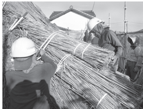
写真4 山口家屋根葺き替え工事
