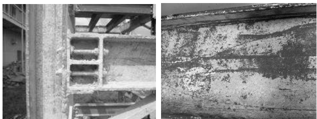
(c) 耐火被覆の接着痕(タイプ3, 左:接合部, 右:一般部)
