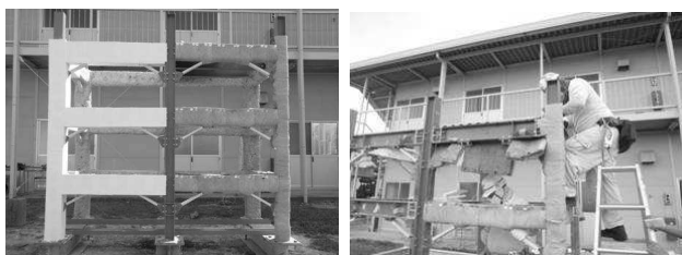
(a) 解体前の耐火被覆 (b) タイプ1
