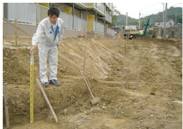
写真 221 敷地切り下げ部土層断面 (南西から)
