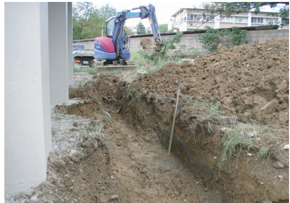
写真 217 F地点掘削状況 (南西から)
