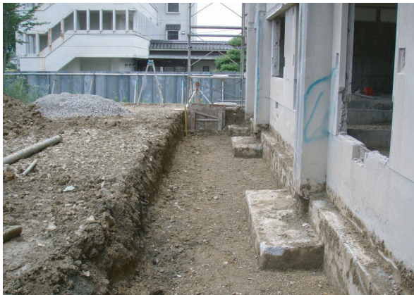
写真 216 E地点掘削状況 (東から)
