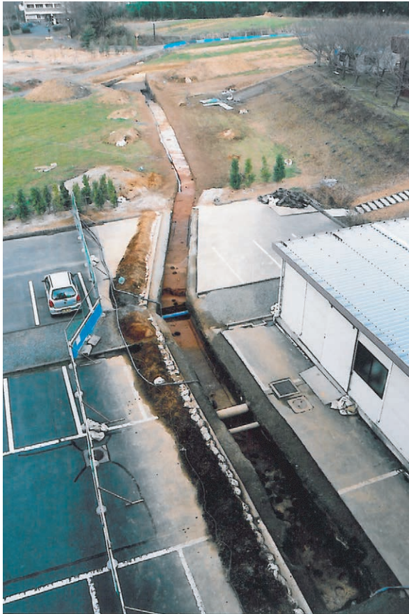
写真33 調査区全景(南西から)
