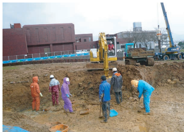
写真114 機械掘削 (2月20日 北から)
