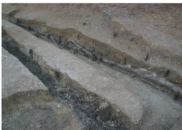
写真111 D-3区水田暗渠(南から)
