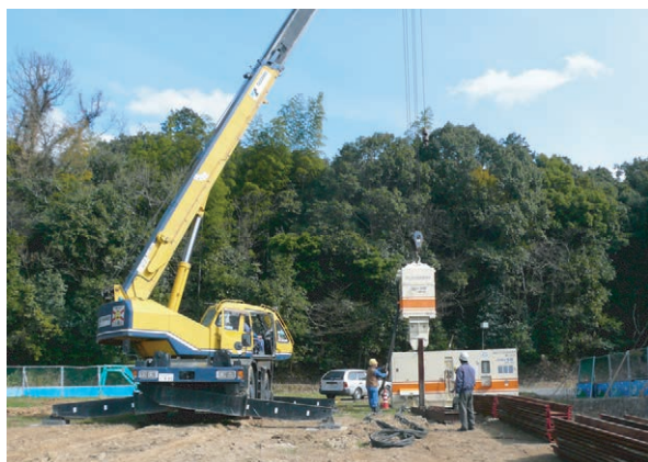
写真113 矢板設置 (2月18日 西から)
