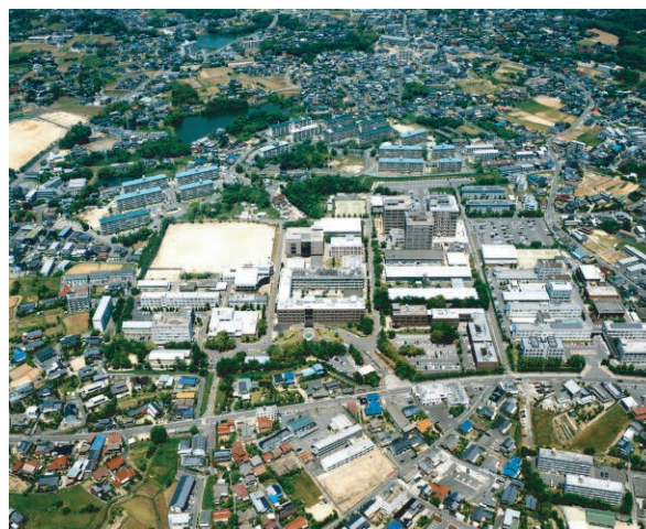
写真5 常盤構内航空写真（南から）
