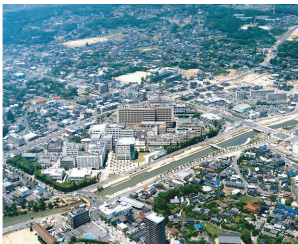
写真4 小串構内航空写真（南東から）
