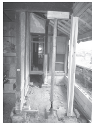
(c) 基礎打設 (d) 柱根継ぎ (e) 柱交換
