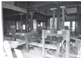
(a) 北面居室ジャッキアップ (b) 台所ジャッキアップ・ブロック腰壁設置
