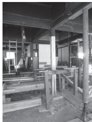
(c) 基礎打設 (d) 柱根継ぎ (e) 柱交換
