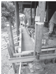
(c) 基礎打設 (d) 柱根継ぎ (e) 柱交換
