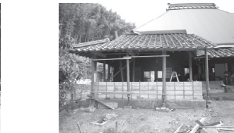
(a) 北面居室ジャッキアップ (b) 台所ジャッキアップ・ブロック腰壁設置
