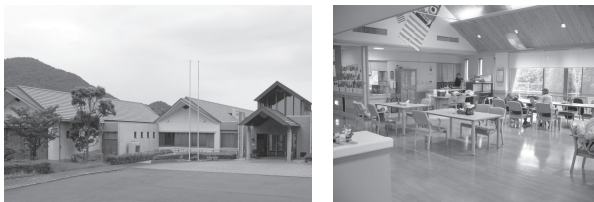
写真1 広域基幹施設
