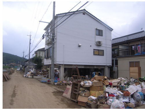
写真7 佐用地区の佐用川沿いに建てられた1階が駐車場の住宅 (佐用町佐用, 2009年8月11日撮影)
