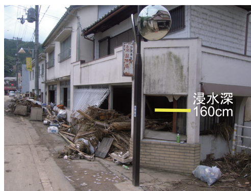
写真5 佐用地区の商店街における洪水被害の状況 (佐用町佐用、2009年8月11日撮影)
