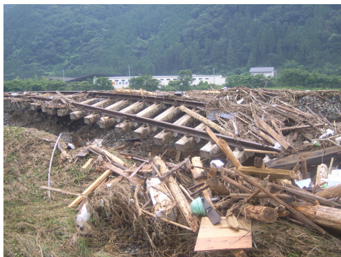
写真8 佐用地区のJR姫新線の洪水被害の状況 (佐用町佐用, 2009年8月11日撮影)
