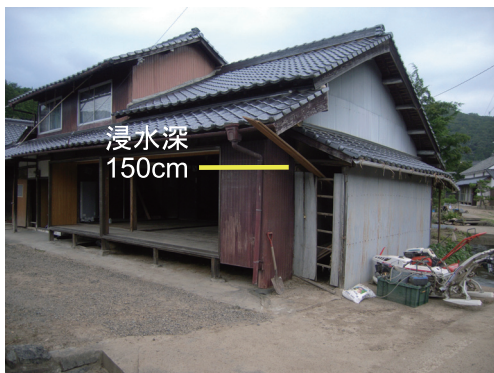
写真10 仁位地区における住家の洪水被害の状況 (佐用町平瀬, 2009年8月11日撮影)
