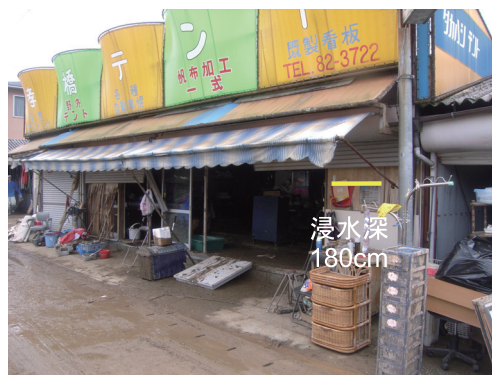
写真4 佐用地区の佐用川沿いにおける洪水被害の状況 (佐用町佐用、2009年8月11日撮影)
