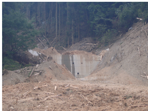
写真11 見土路地区における砂防ダムによる土砂流防止の状況 (佐用町見土路, 2009年8月11日撮影)
