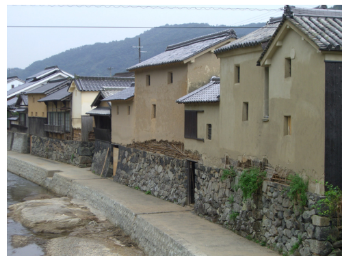
写真2 平福地区の作用川に面した土蔵群における洪水被害の状況（佐用町平福，2009年8月29日撮影）
