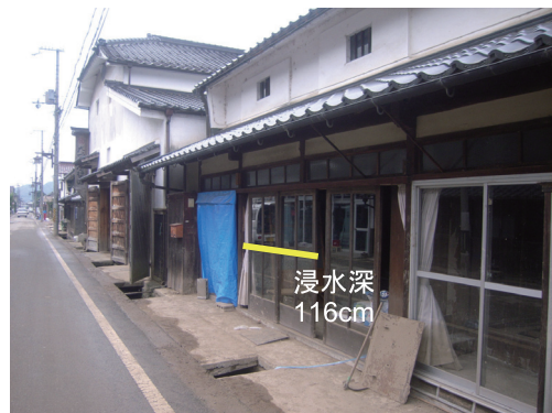
写真1 平福地区における浸水被害の状況（佐用町平福，2009年8月29日撮影）
