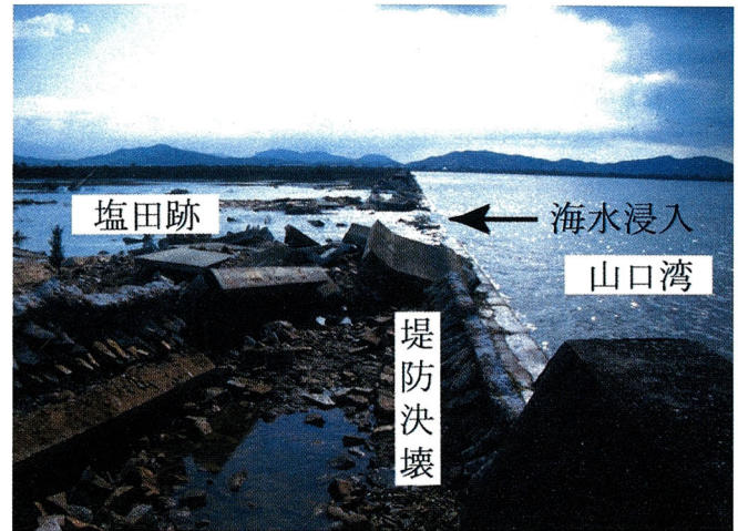
第 10 図 台風 18 号に伴う高潮による海岸堤防の決壊状況(山口県山口市秋穂二島幸崎, 1999 年 9 月 25 日撮影)。
