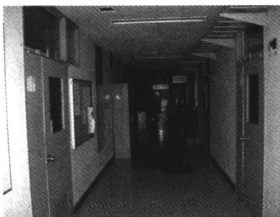
Fig 7 共通研究1号館1階廊下の暗さ
