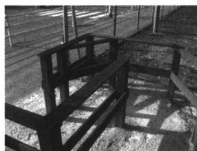
Fig. 6 特別支援学校付近通用門 自転車の飛び出しによる事故を防ぐ柵。
