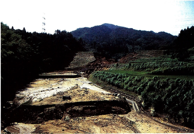
第6図 麻生溜池の堤体崩壊と土砂流出の状況 (1997年7月31日撮影)。
