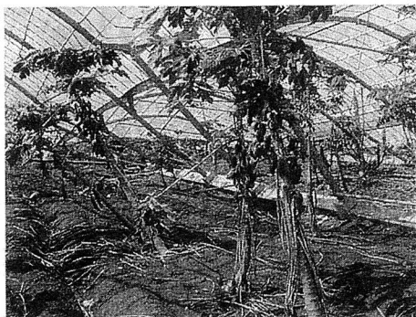
写真2 倒壊した鉄骨マンゴハウスの被害 (2003年10月10日撮影、下地町川満)
