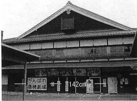
写真1 嘉穂劇場における浸水の状況 (浸水深：142cm)
