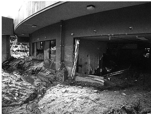
写真1 ライフケア高砂における土石流被害の状況（防府市真尾，2009年7月25日撮影）
