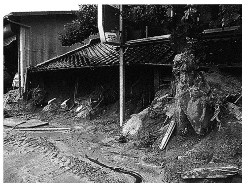
写真5 土石流による家屋の被害状況 (防府市下右田, 2009年7月25日撮影)
