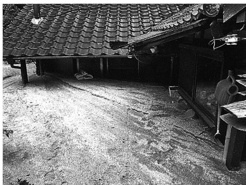
写真4 土砂流による家屋へのマサ土の堆積 (防府市十七, 2009年7月25日撮影)
