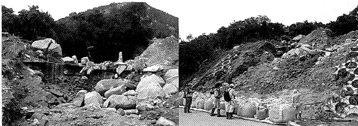
図26 下右田地区の土石流。破壊された流路末端の断面
