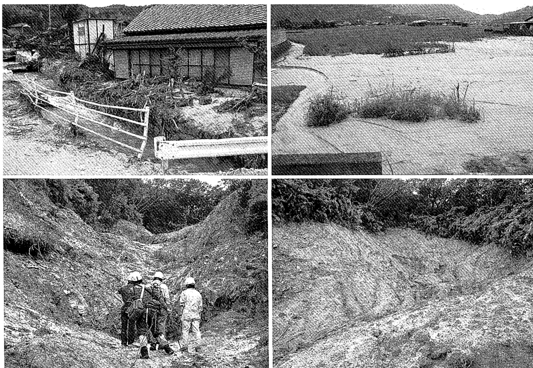
図20 上左：奈美地区の土石流渓流，上右：平地の田圃に流出した砂。下左，下右：源頭部崩壊の状況。
