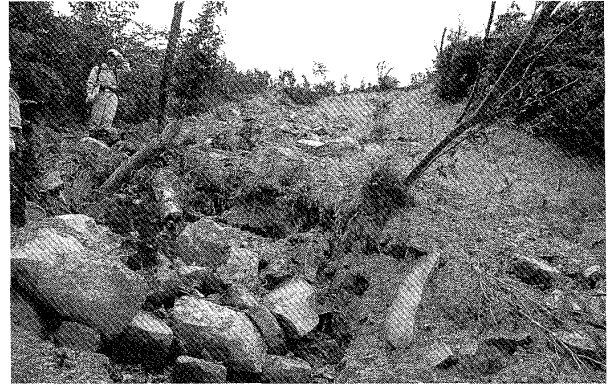
図15 図7の谷頭の小規模崩壊を下から見上げた写真。
