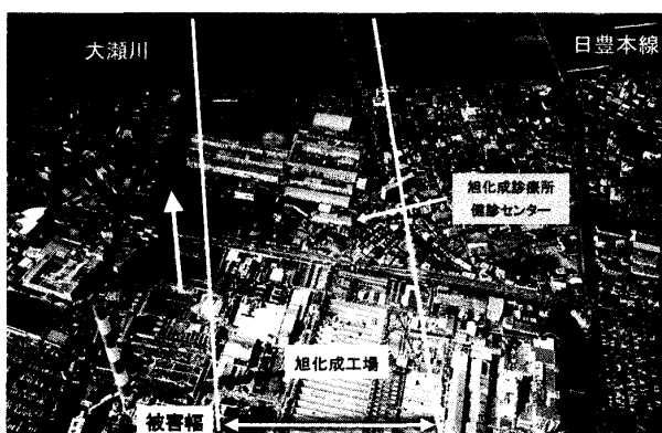
写真10 旭化成の工場等の被害状況（旭町，2006年9月19日撮影）
