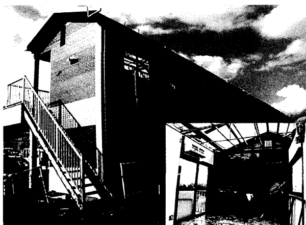
写真5 アパートの被害状況（浜町、2006年9月19日撮影）
