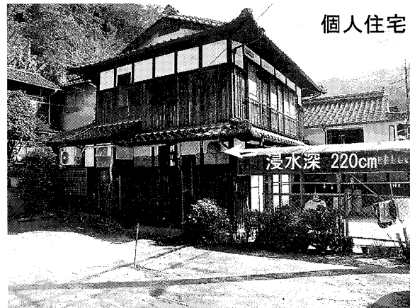
写真5 個人住宅における浸水被害の状況（山口県玖珂郡美川町南桑，2005年9月25日撮影）
