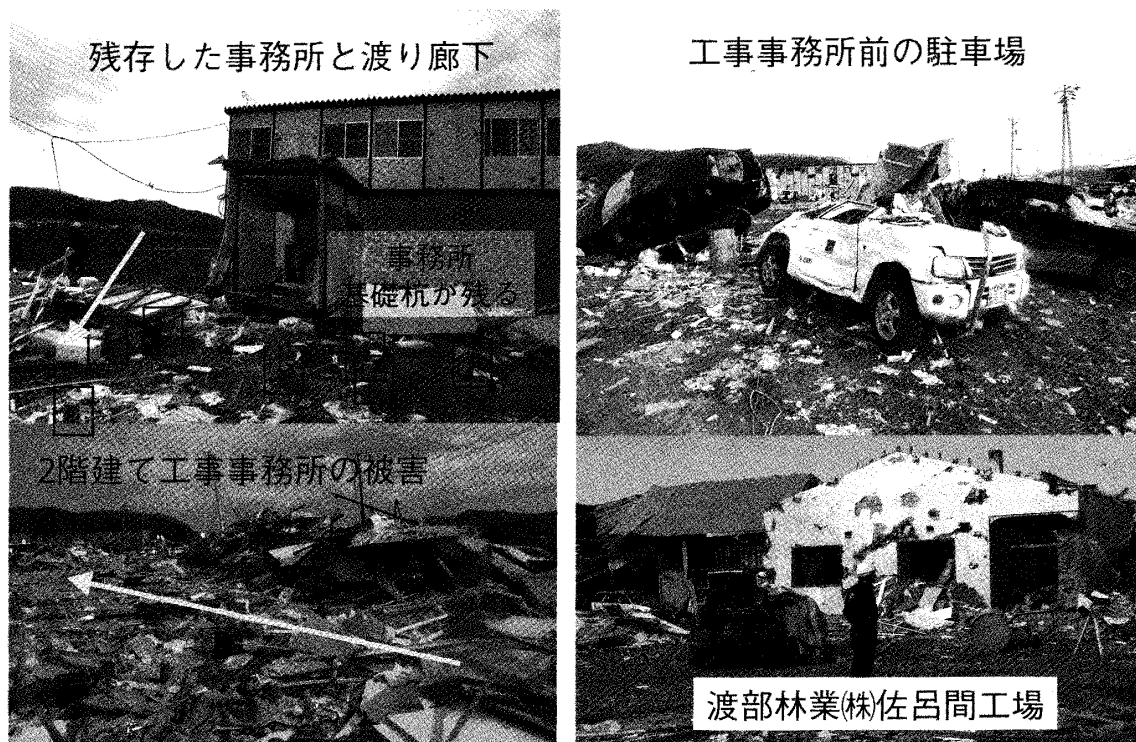
写真4 新佐呂間トンネルJV工事事務所および被害 (2006年11月9日撮影)
