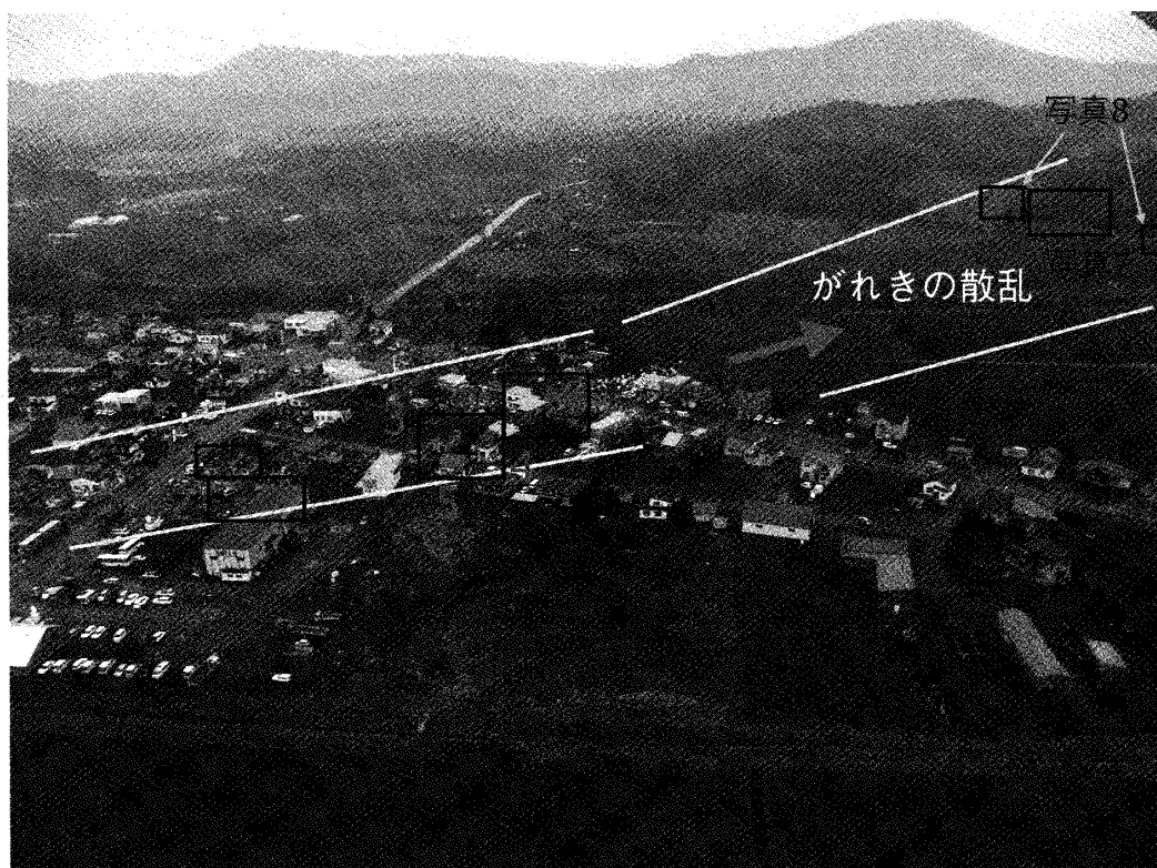
写真5 若佐地区中心部の被害 (2006年11月10日撮影) (数字は、写真6の数字と一致する)
