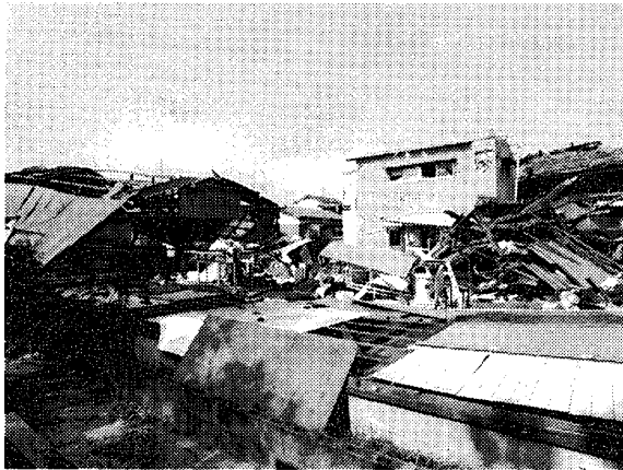
写真3 竜巻による縫製工場の被害状況（佐賀市本郷新町，2004年6月30日撮影）
