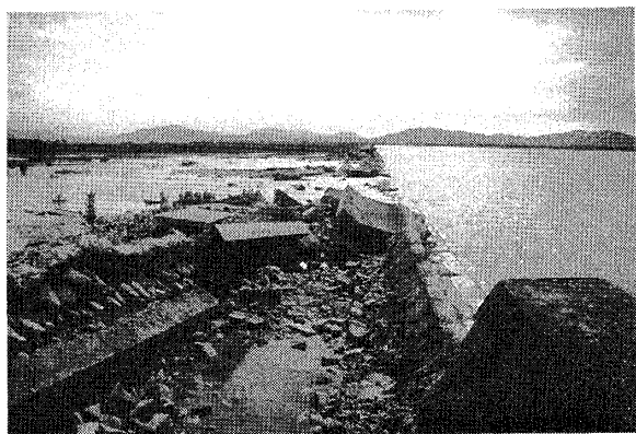
写真4 高潮により決壊した堤防の状況（山口県山口市秋穂二島幸崎，1999年9月25日撮影）
