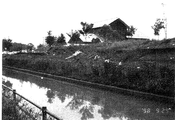
写真3 高知県立美術館の前を流れる排水路の法面に残されたごみの状況（高知県高知市高須，1998年9月29日撮影）
