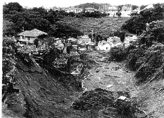
写真2 墓地の土砂崩壊により住宅を襲った土石流の状況（高知県高知市横浜西町，1998年9月26日撮影，高知新聞社提供）
