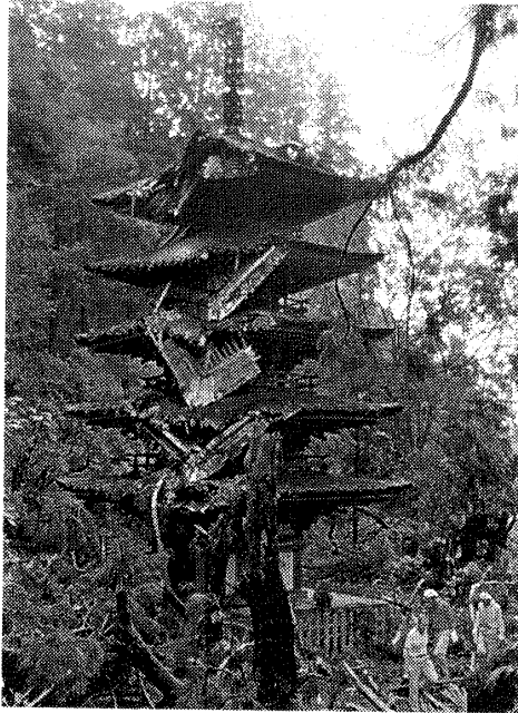
写真3 強風に伴う倒木による国宝の室生寺五重塔の屋根の損壊（奈良県宇陀郡室生村室生，1998年9月23日撮影，読売新聞大阪本社提供）
