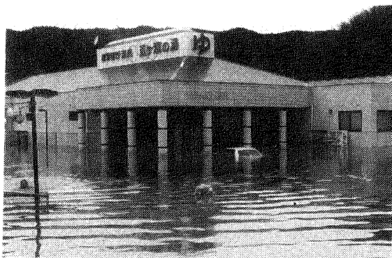
写真3 五ヶ瀬川の氾濫による建物の浸水状況（宮崎県延岡市古川町，1997年9月16日撮影，夕刊デイリー新聞社提供）
