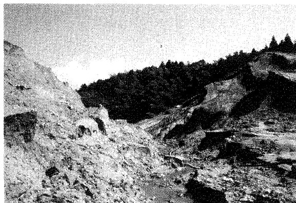
写真1 豪雨により決壊した麻生溜池の堤体の崩壊の状況(山口県阿武郡むつみ村吉部上尾の坂, 1997年7月30日撮影)
